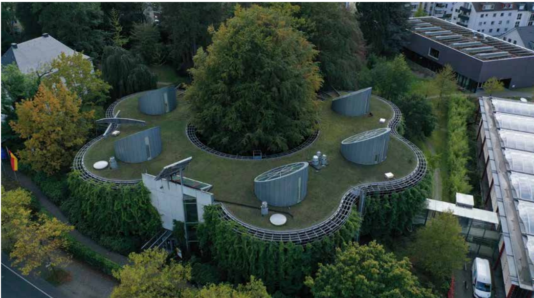
Das DBU-Gebäude in der Phase der Fertigstellung (oben) ... und in einer Aufnahme aus dem Jahr 2020 (unten).
